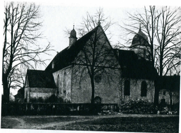
30. Pfarrkirche „St. Johannes“ vor der Erweiterung 1936
